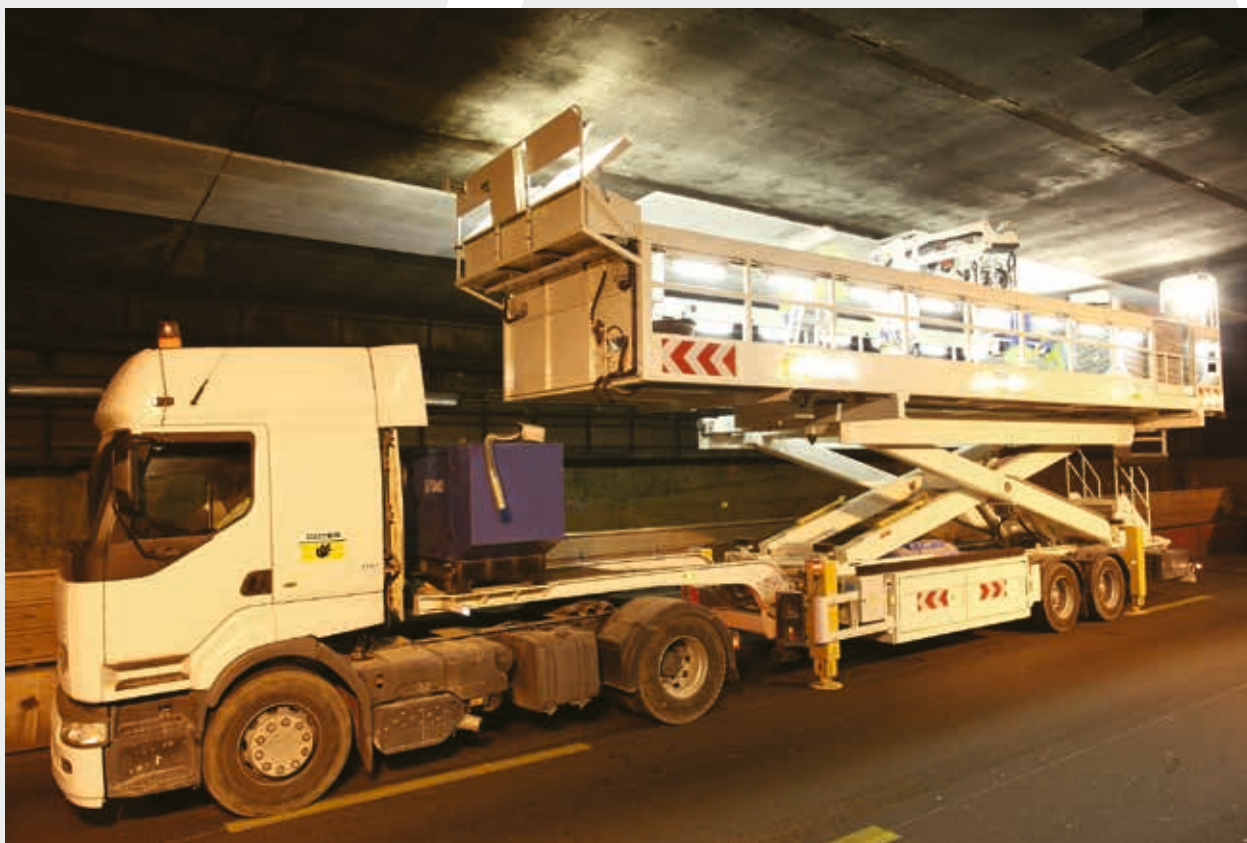
Travaux de sécurisation du tunnel du Landy, Saint-Denis (93), DIRIF.
