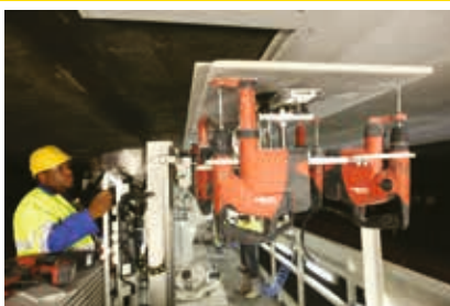
Positionnement et mise en place.
